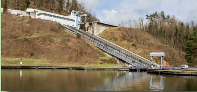
Das Schiffshebewerk von Arzviller ist ein Schrägaufzug im Laufe des Rhein-Marne-Kanals, der einen Höhenunterschied von 45 Metern durch die Vogesen überwindet. Schiffe mit bis zu 900 Tonnen können auf dem Kanal ihre Fracht transportieren.
